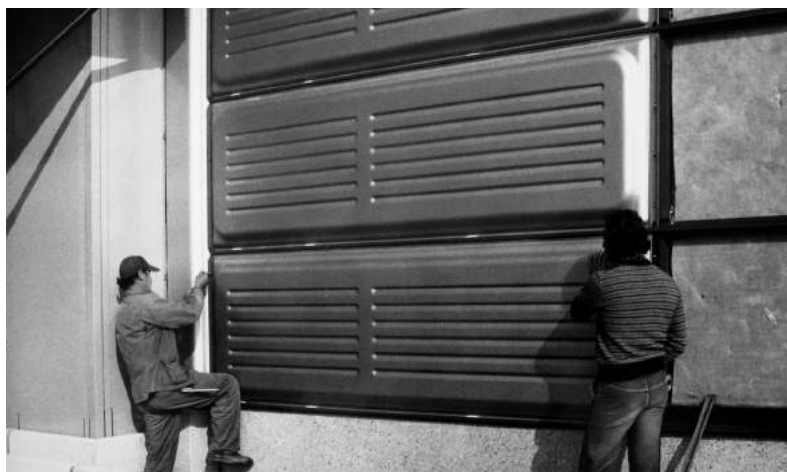
Montage des panneaux
