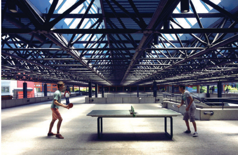
Les passerelles au-dessus de l'avenue Piccard
