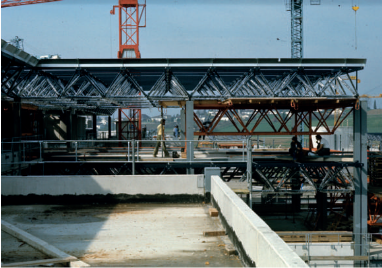
Montage de la structure tridimensionnelle
