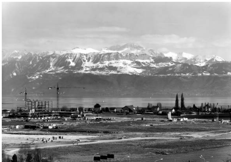
Le début du chantier en 1973
