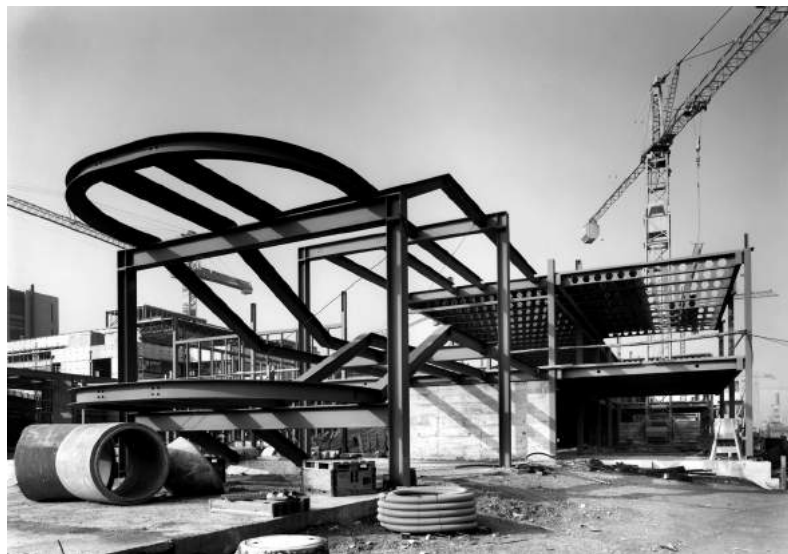
La structure standardisée et les limons de l'escalier pignon de l'axe central
