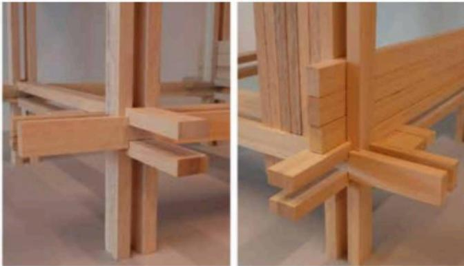
Système d'assemblage tiré du vernaculaire japonais, réinterprété avec les outils à ma disposition et composé d'un seul type de planche pour toute la structure et l'enveloppe. Les hauteurs de celle-ci permettent aussi d'avoir une couverture à double pente.
